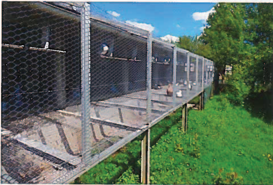
Vue générale d'une partie des volières avec les façades munies de balcons posés sur caillebotis
